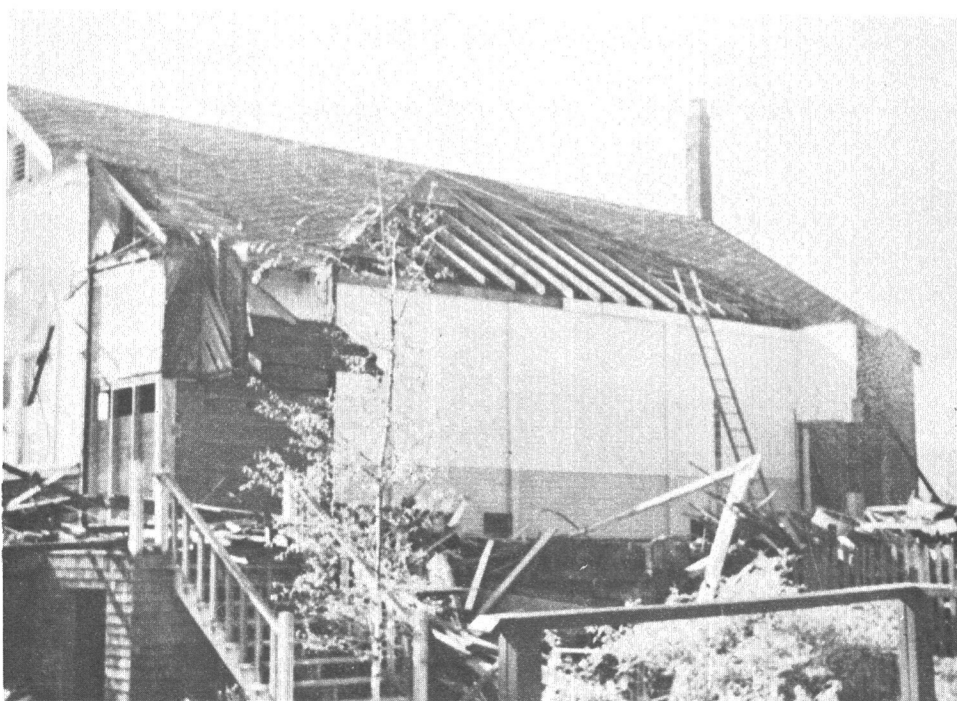
Das Gebaeude zwischen Kirche und Pfarrhaus wird abgebrochen.
